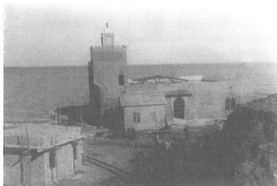
4. Castillo del Bil Bil en obras. 1934.
